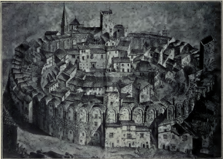
22. Amphitheater in Arles, in eine besetzte Stadt umgebaut.
